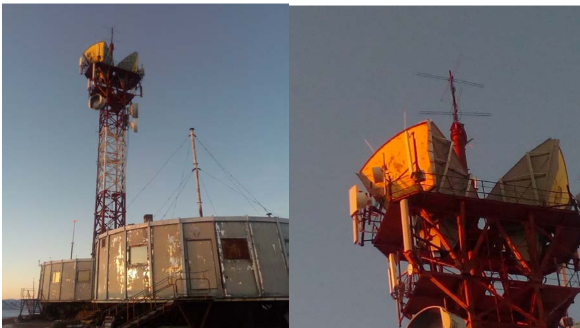
Зураг 11. Булган аймгийн радио релейний 162-р цамхаг. Тус цамхагт байрлах RCAG PAE T6 радио станцын антенны байдал.
