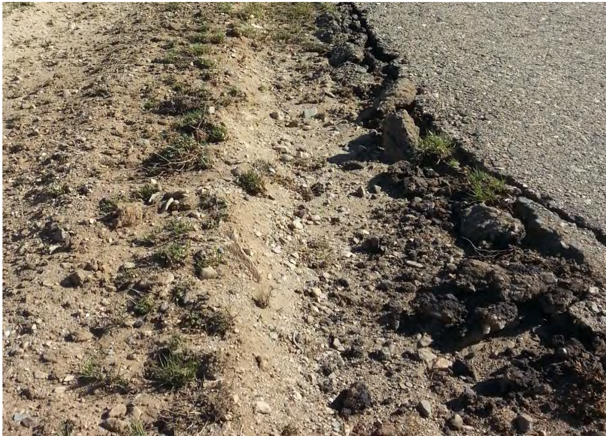
Зураг 40. Хөөрөх буух зурвасны хажуугийн аюулгүйн зурвасны хөрсний суулт
