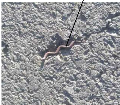
Зураг 24. Бетон талбайд цутгагдсан төмөр /5см/
